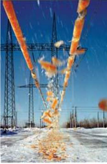
Resim 1.8: Buzun iletkenlere etkisi
